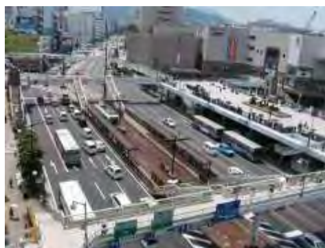
国道 202 号（長崎駅前電停）の現状
