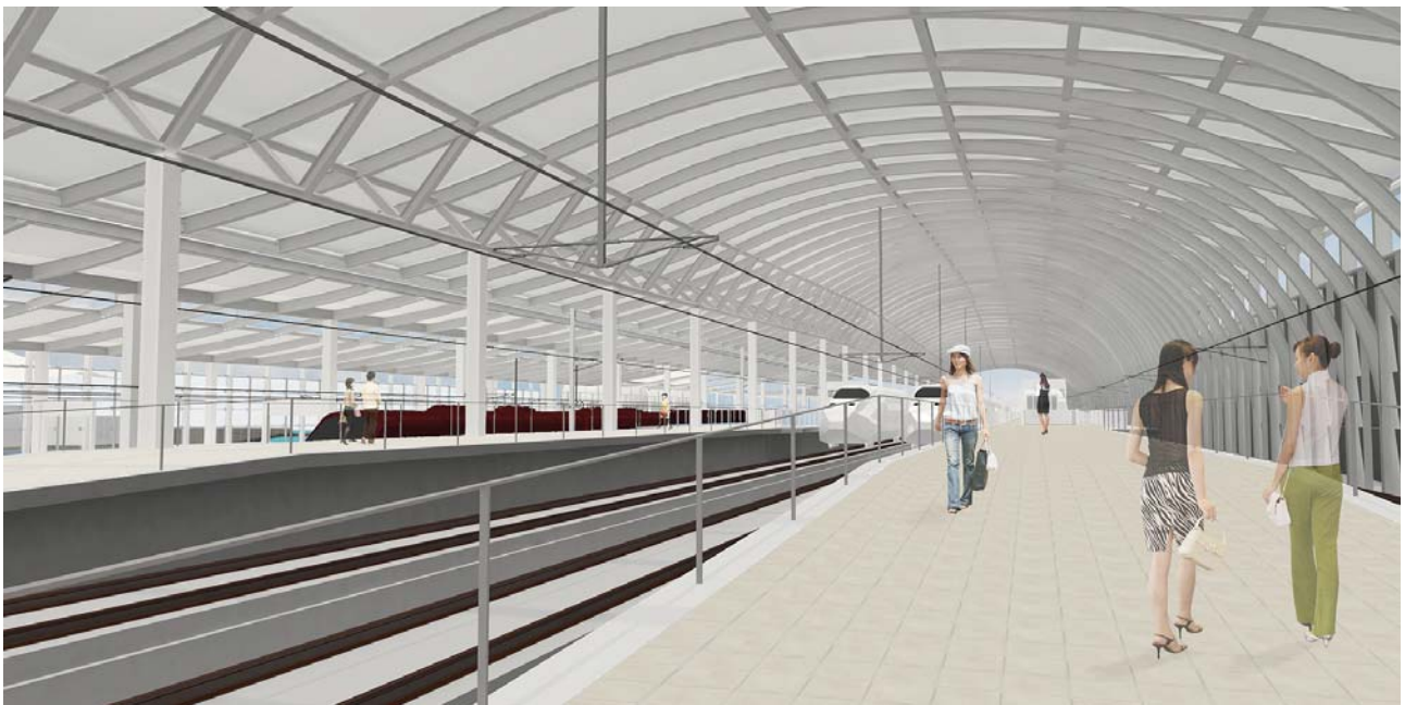
【南側歩行者通路から北側を見通す】
