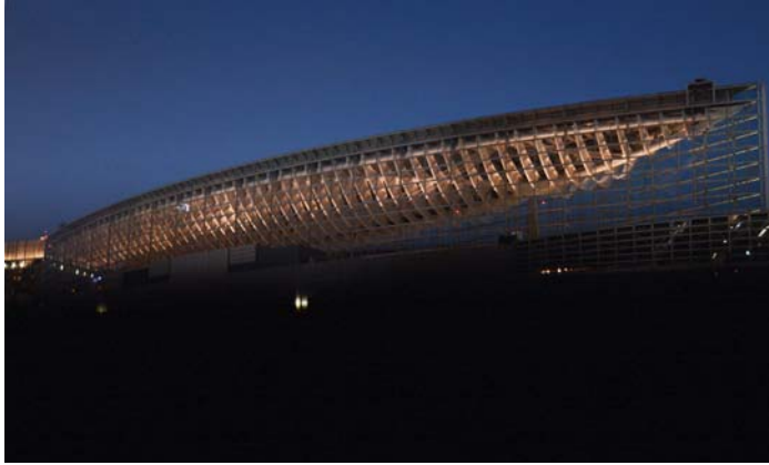
ガラスホールの構造体を約 600 灯の照明で照らし上げ、建築の特徴を表現している。 [東京都/東京国際フォーラム]
