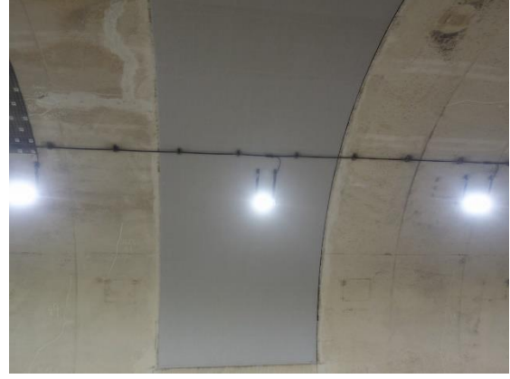
覆工補強対策（炭素繊維シート接着工）
