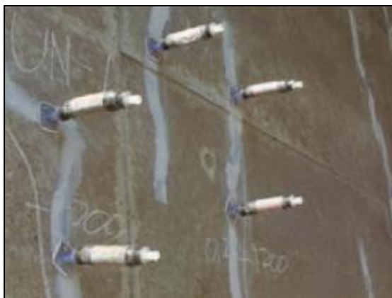
はく落防止対策（ひび割れ注入工）
