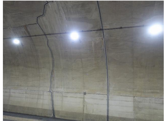
漏水対策（導水工）
