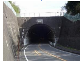
2. 長崎卸トンネル L=206m
