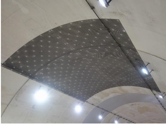
はく落防止対策（FRP メッシュ）
