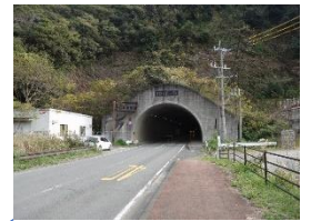
1. 運動公園トンネル L=934m
