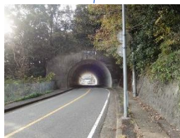
5. 水の浦トンネル L=60m
