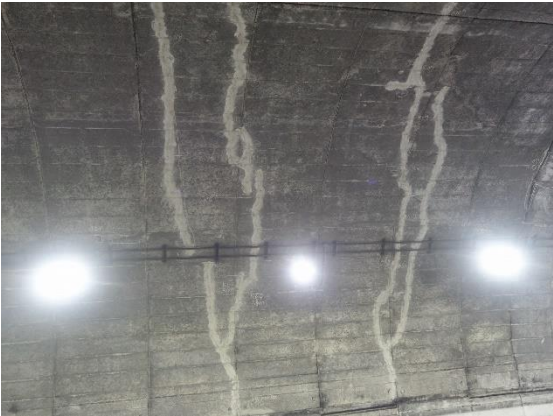
ひび割れ対策（ひび割れ注入工）
