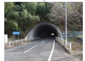
7. 矢上団地トンネル L=292m
