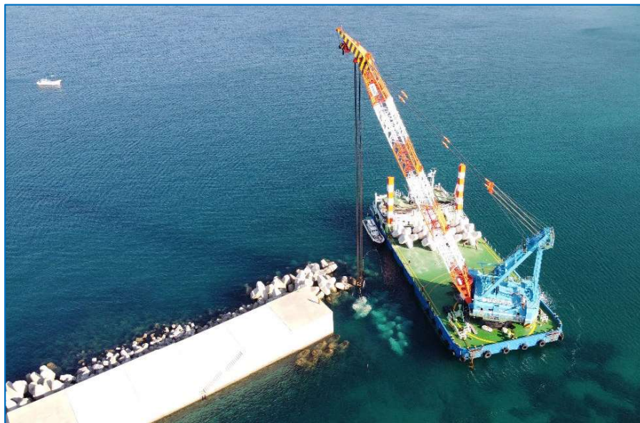
施工中（野野串漁港）
