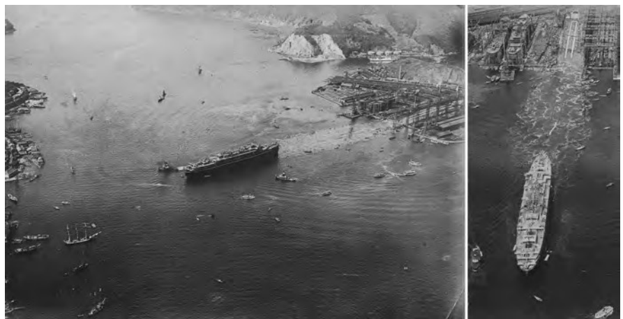
【写真5】第2船台から進水した直後の貨客船「龍田丸」昭和4年4月12日（齋藤蔵） 写真左端には対岸の浪の平が迫る
