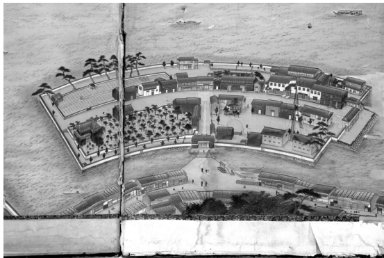
修復以前の出島部分
