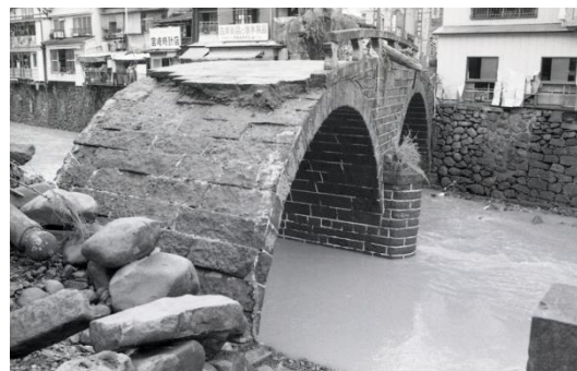
写真 2-23:長崎大水害時の眼鏡橋
