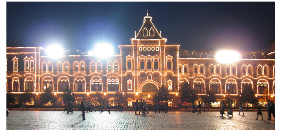
ポール灯のグレアによって建物のライトアップが邪魔されている
