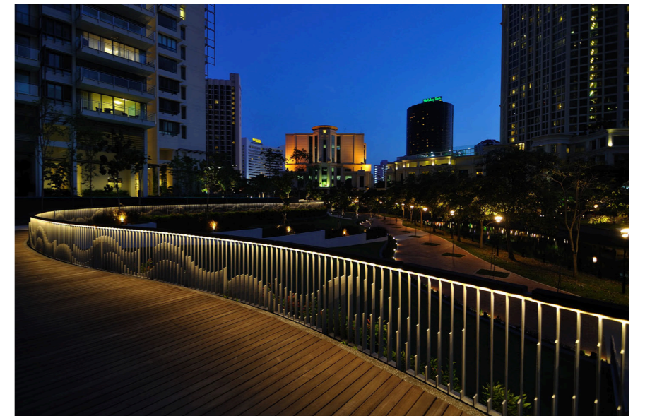
手摺という鉛直面を照らすことで、空間にひろがりを与えながら、効率よく機能的な路面照度も確保している。
