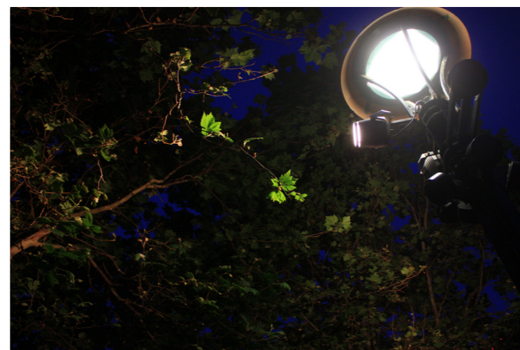
樹木を照らすスポットライトが付いている街路照明の事例（メルボルン）
