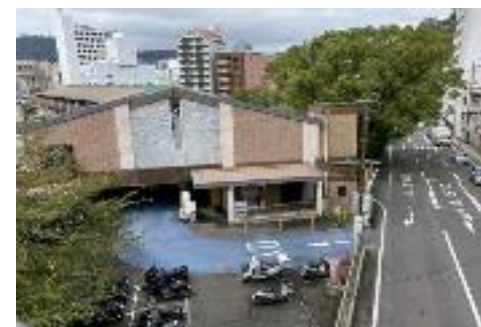
①桜町駐車場 (入口)
