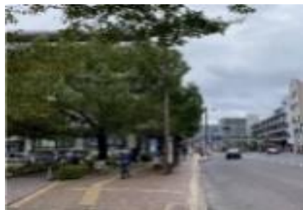
④南側道路
