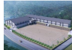
外海中学校 ※ 新校舎建築中
