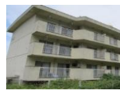
池島教職員住宅第1号/ 池島事務所係長宿舎
