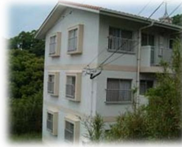
瀬戸屋敷住宅
