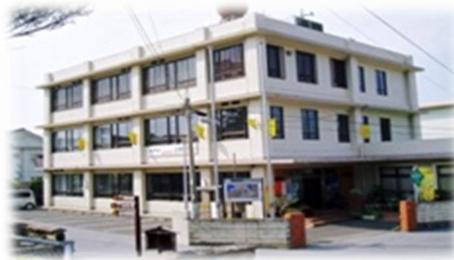
深堀地域センター 築38年
