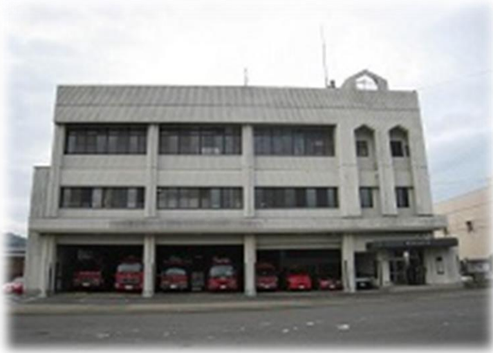
南消防署 築32年
