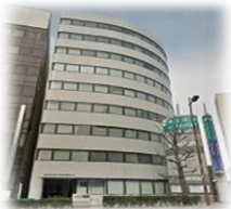
明治安田生命 長崎興善町ビル(借上)
