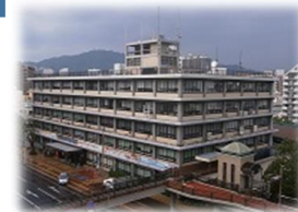
本庁舎・中央総合事務所
