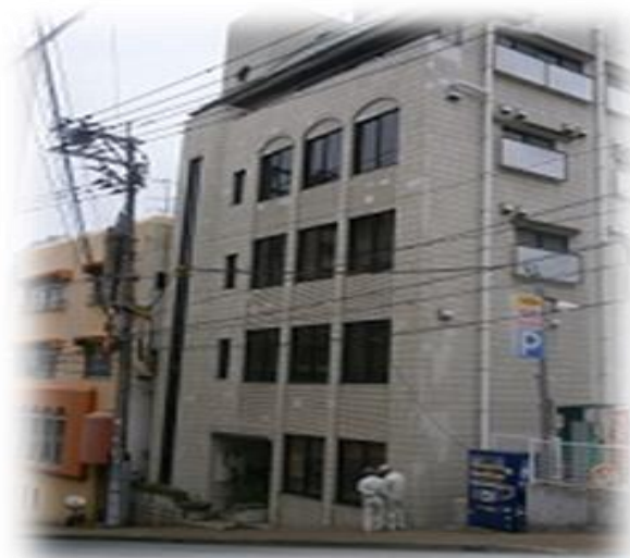
職員会館 築33年
