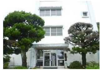
東長崎地域センター 戸石地区事務所
