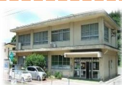
手熊地区 ふれあいセンター
