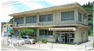
手熊地区ふれあいセンター
