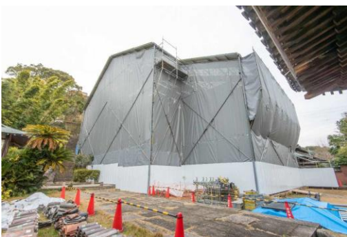
【重要文化財 聖福寺大雄宝殿ほか3棟】
