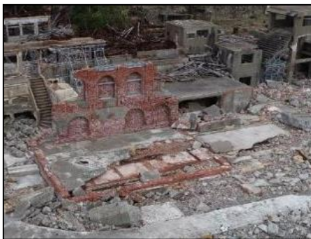
【第3竖坑捲座跡外観】
