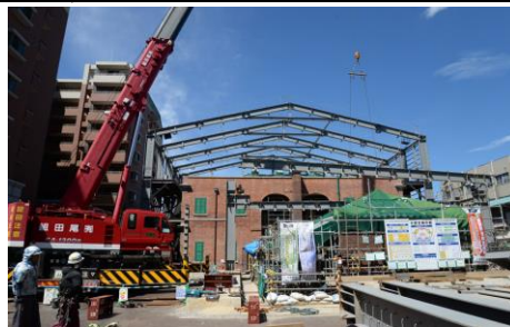
【本館・附属屋の素屋根解体工事】
