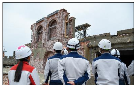
【第3竖坑捲座跡保存整備 施行中】
