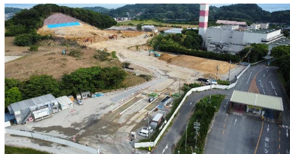
【造成工事(R5.6.29撮影)】
