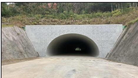
【江平浜平線(トンネル)】
