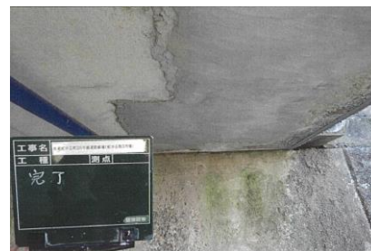
橋梁修繕完了
