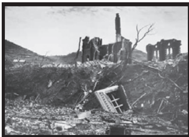
旧天主堂は壁を一部残し崩壊。写真中央下が旧鐘楼。 (H.J.ピーターソン氏撮影／長崎原爆資料館蔵)
