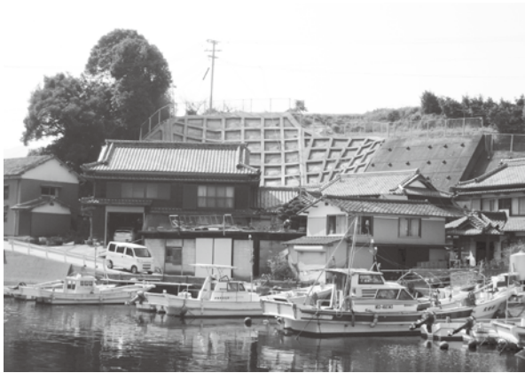
▲急傾斜地崩壊対策事業の施工箇所
