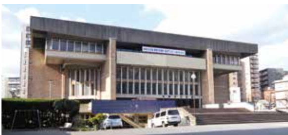
▲閉館した公会堂の場所に新市庁舎の建設を予定
