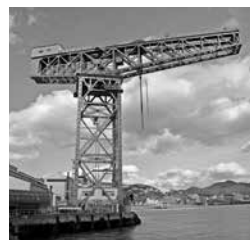
三菱長崎造船所 ジャイアント・ カンチレバークレーン (非公開施設)
