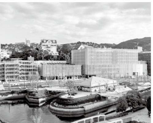
▲平成29年1月に全ての工事が終わり グランドオープン
