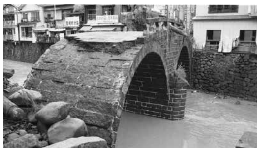
増水した中島川と破損したためがね橋(昭和57年撮影)
