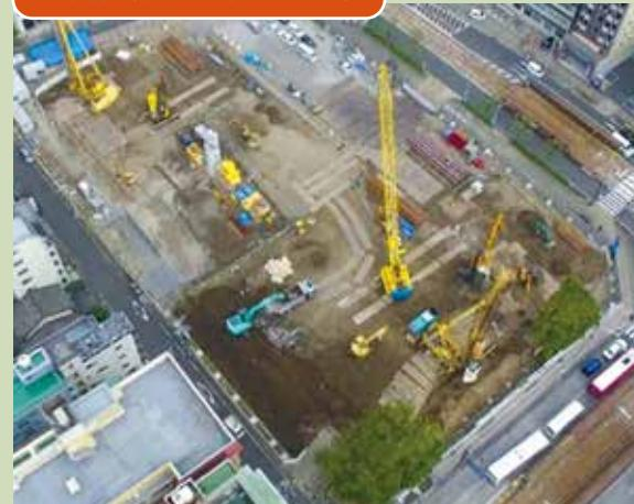
地下を掘ったときに周囲の土が流れ込まないように山留工事をしています
