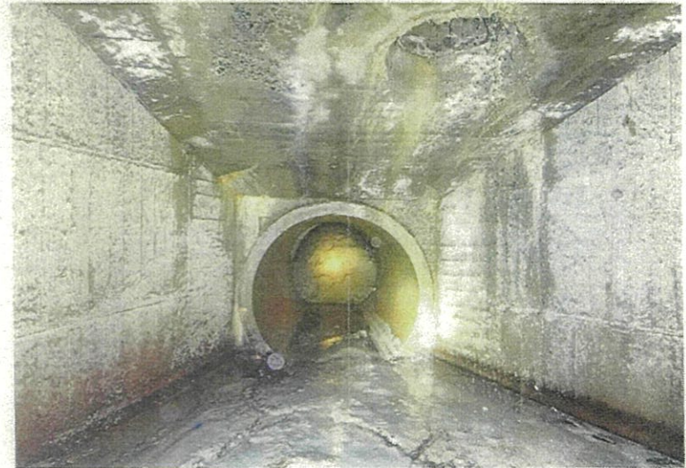
④旧水路干渉箇所
