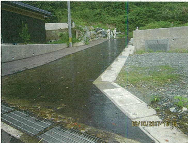
③北側の地下水
