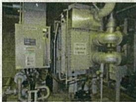
資料館内の冷暖房を行うための冷温水発生機 2 台の内 1 台 (2 号機)について、分解点検及び部品の取り換え(オーバーホール)を行う。
