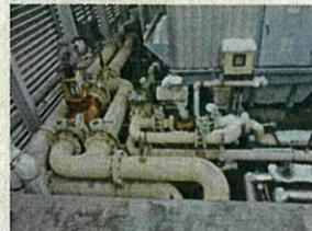
原爆資料館屋上に設置している冷却塔の電動三方弁が経年劣化しているため、取替工事を行う。
