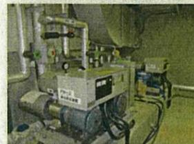
原爆資料館の市水及び井水を汲み上げるポンプが経年劣化しているため、同ポンプ 2 台の取替工事を行う。
