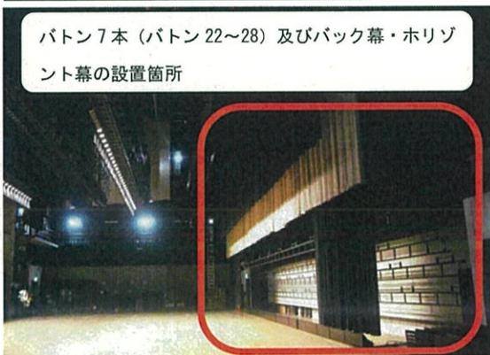
内容：全体で 28 本あるバトン（幕等を吊る吊物）のうち舞台後方部の 7 本及びバック幕、 Horizont 幕の駆動部（①駆動マシン（ブレーキ電源含む）・②ワイヤーロープ・③滑車・④リミット（停止制御）スイッチ）及び制御盤の取替等を行う。
