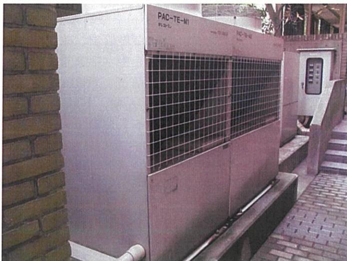
内容：パッケージエアコン（地下1階（舞台係員控室）、1階（中央監視室・守衛室・ピアノ庫・交流スペース）、2階（映写室・音響室・調光室・親子室・調光基盤室）の室外機9台及び室内機25台の更新を行う。
