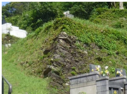
角の飛び出した石が見られる石垣
