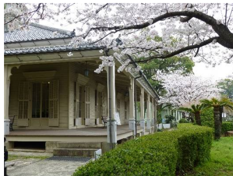
東山手地区内の木造洋風建築
