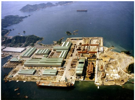
昭和47年（1972）10月 世界に誇る新鋭設備香焼工場竣工（三菱重工業㈱長崎造船所所蔵）
