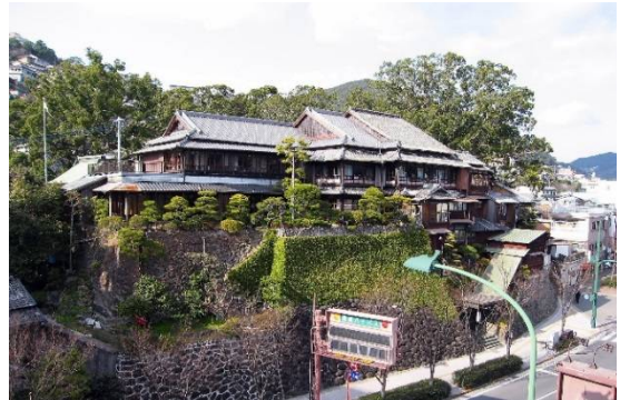
平成 30 年に解体された料亭富貴楼
