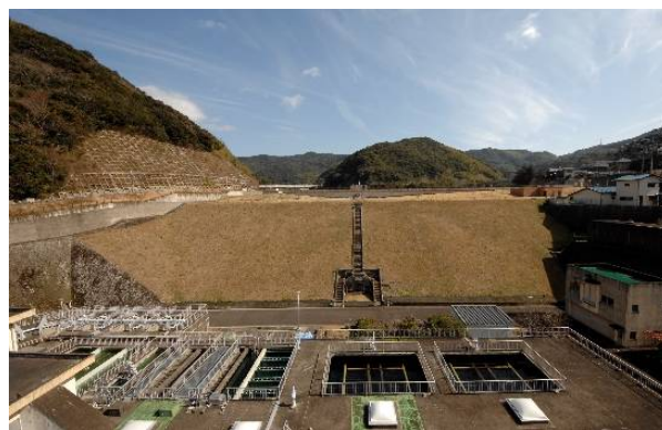
本河内高部水道施設（堰堤）
