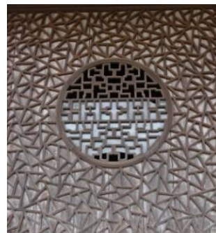
大雄宝殿の氷裂式組子
