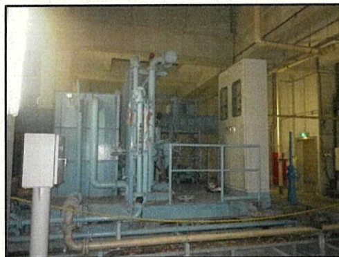
既設沈砂設備
