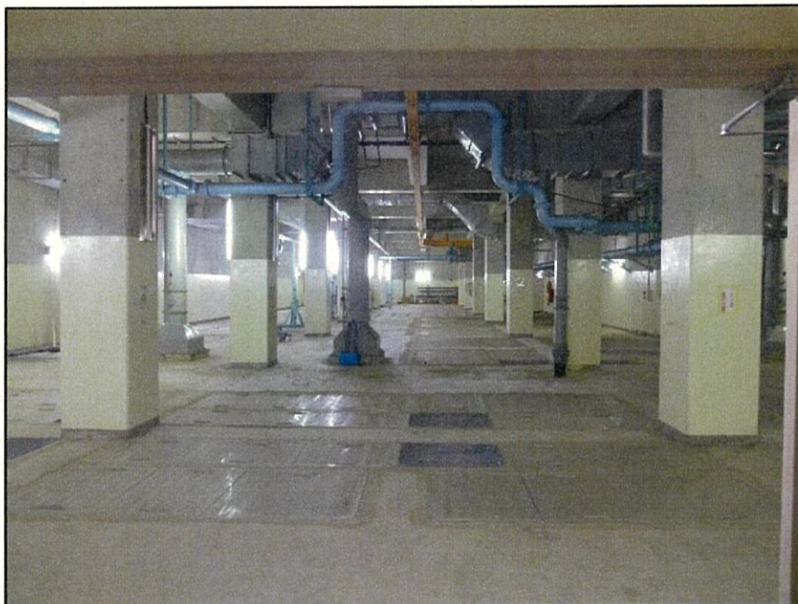
旧クリーンセンター 地下1階部分
