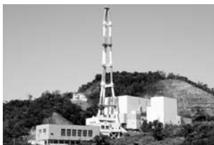
建替計画が検討されている西工場
