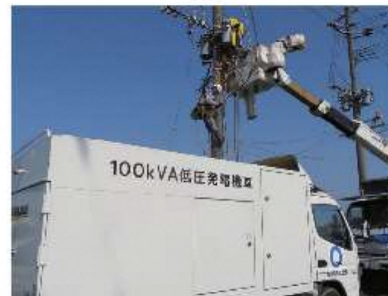
復旧作業の様子
