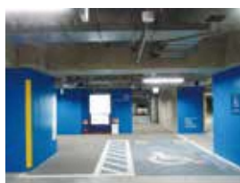
▲市庁舎地下駐車場
