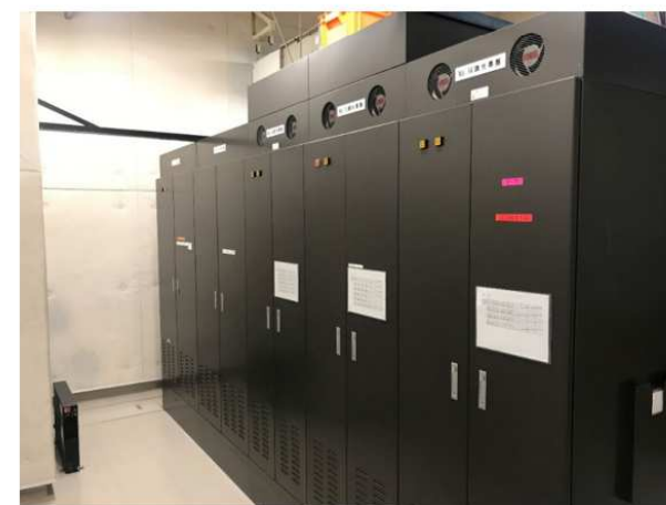
現状写真 (調光主幹盤・調光分岐盤・調光器盤)
