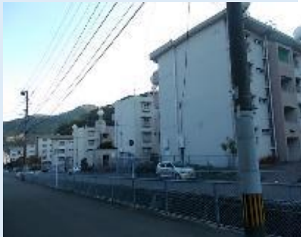
日見大曲住宅 (3棟48戸)
