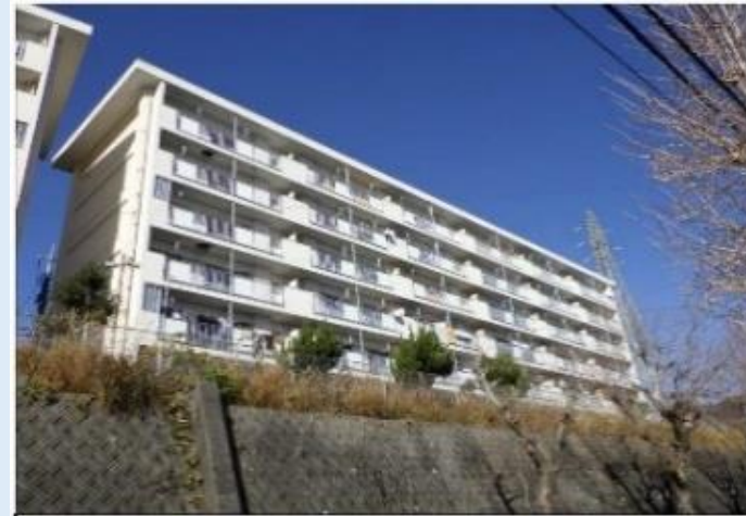
2号棟 (36戸) RC造6階建て
