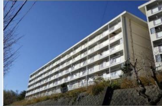
1号棟 (48戸) RC造6階建て
