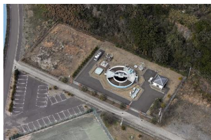
高島浄化センター
