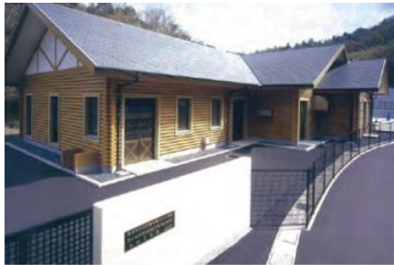
高浜農業集落排水処理施設
