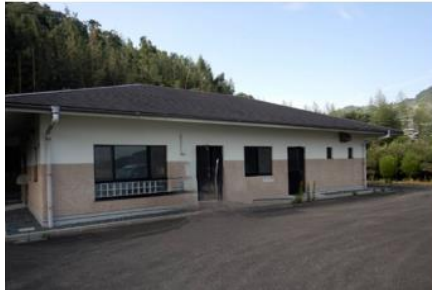
太田尾農業集落排水処理施設
