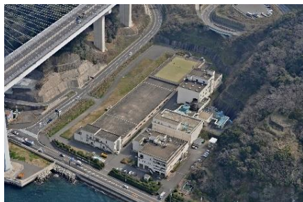
南部下水処理場
