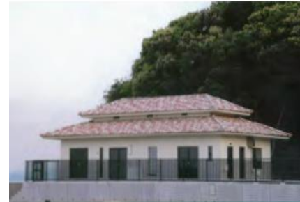
小口農業集落排水処理施設
