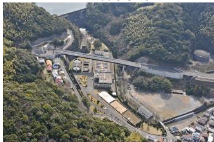
小ヶ倉浄水場
