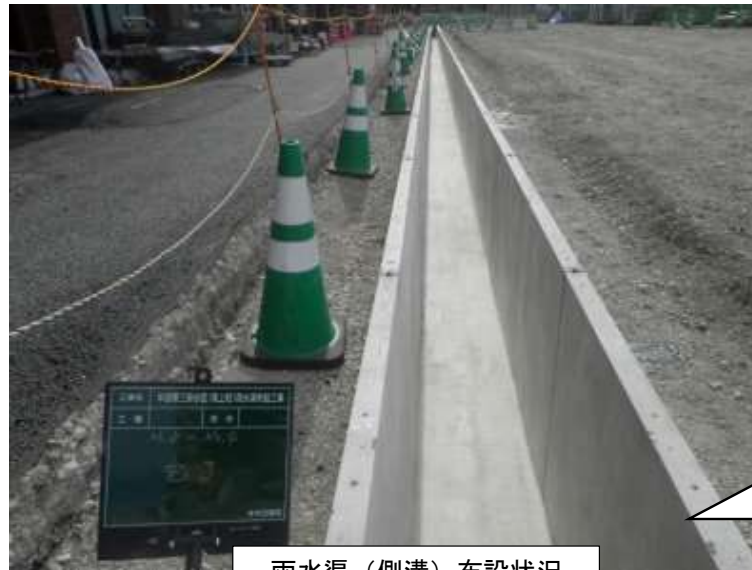
雨水渠（側溝）布設状況
