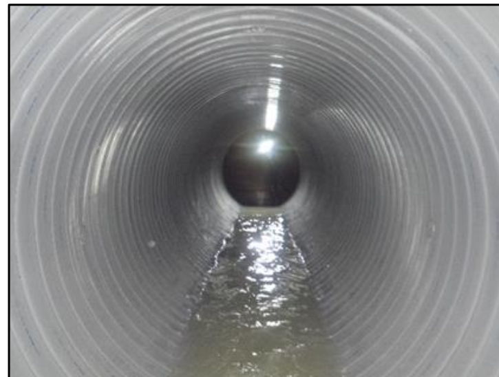
老朽管の中に新しく設置された更生管
