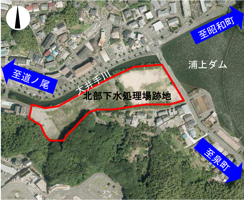
新浄水場建設予定地
