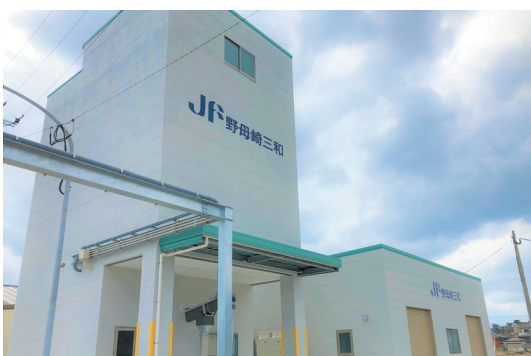
製氷・冷凍施設
