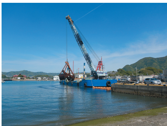
漁港整備（浚渫*）
