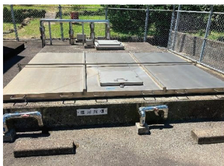
写真 8-32 スラブ蓋（施設撤去のため対策不要）
