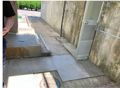
写真 8-3 配管室入口ドア
