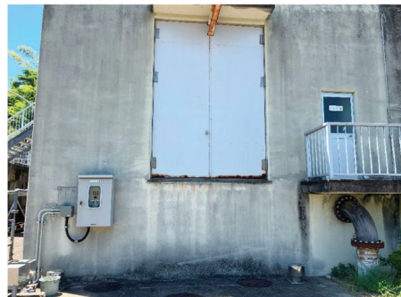
写真 8-15 ポンプ室入口ドア、搬入扉
