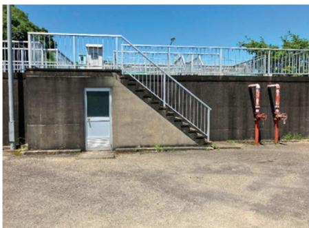
写真 8-22 配管室入口ドア
