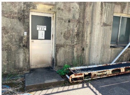
写真 8-17 配管室入口ドア
