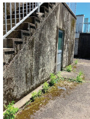
写真 8-20 配管室入口ドア
