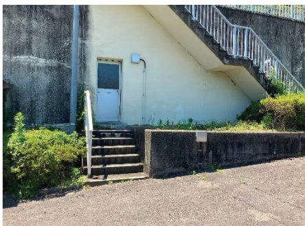
写真 8-6 配管室入口ドア
