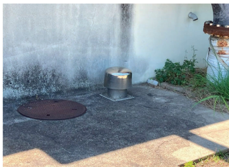
写真 8-16 換気塔（対象外）
