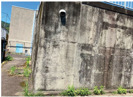
写真 8-20 換気口（対象外）
