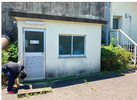
写真 8-7 入口ドア、窓、ガラリ
