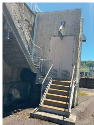
写真 8-10 ポンプ室搬入扉
