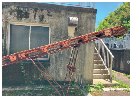
写真 8-19 配管室窓、換気口
