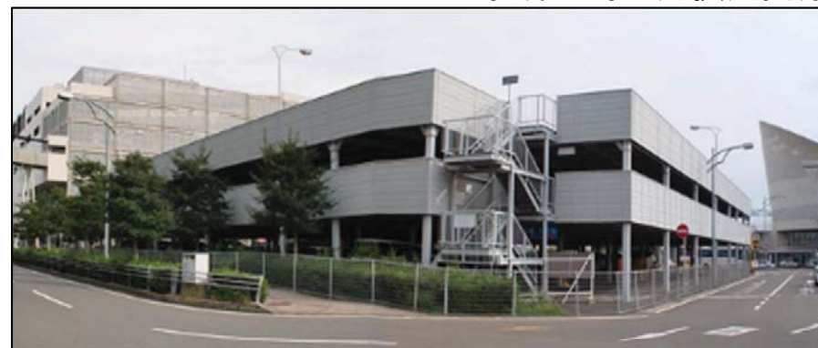
長崎港ターミナルビル駐車場 平成11年4月供用開始
