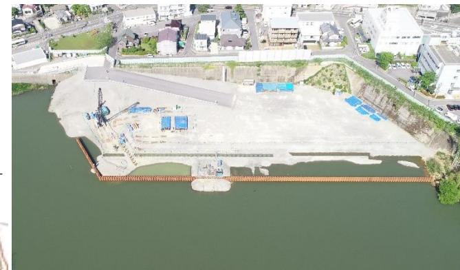
仮設ヤード工 (R7.5時点)
