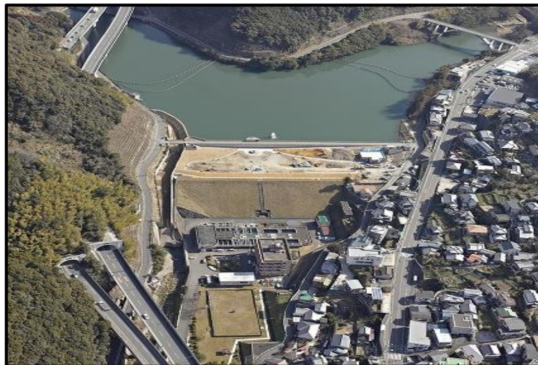
※本河内高部ダム 明治24年築造
