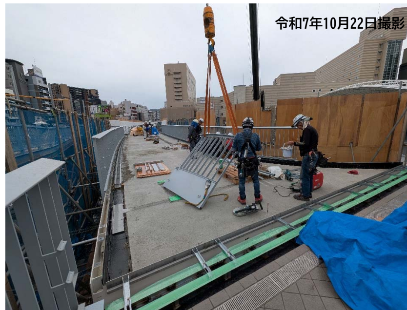
橋面作業状況（高欄・排水側溝の設置）
