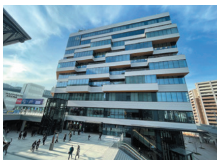
【誘致企業が入居するオフィスビル [STADIUM CITY NORTH]】
