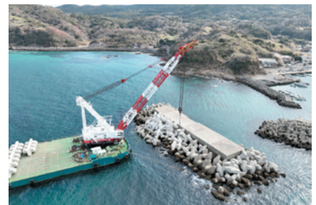
【野野串漁港沖防波堤改良】
