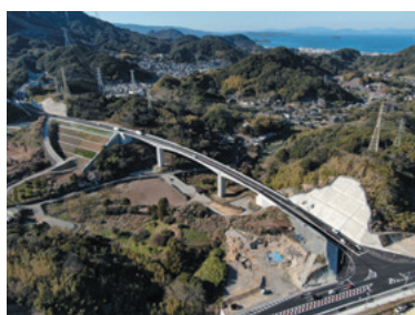
【完成した高規格道路* (西彼杵道路(時津工区))】
