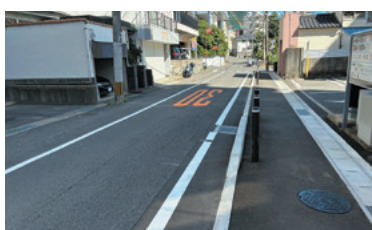
【歩道整備 (市道西坂町玉園町1号線)】
