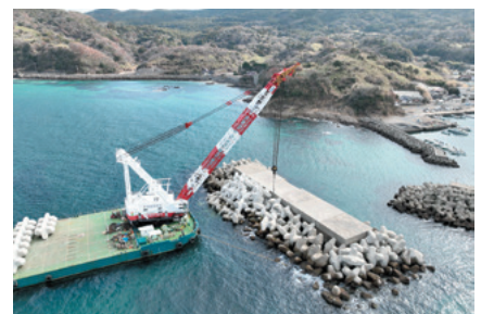
【野野串漁港沖防波堤改良】
