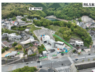
【整備中の高規格道路* ((主)長崎南環状線)】 出典：長崎県HP「[長崎南環状線] 工事の進捗状況 (令和7年7月末時点)」より
