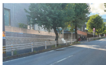
【ガードパイプの設置 (市道滑石横尾線)】
